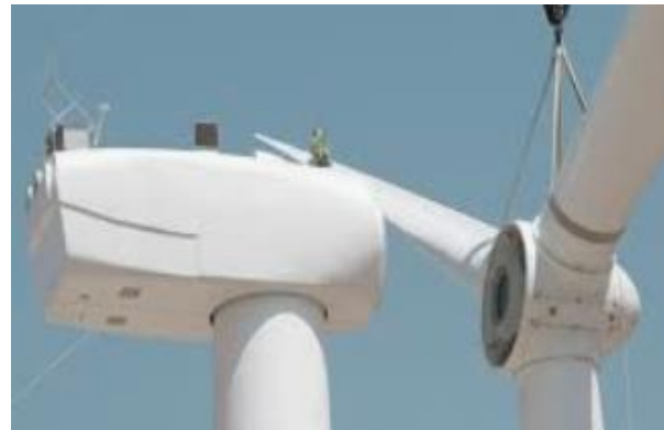
Assemblagem de aerogeradores
