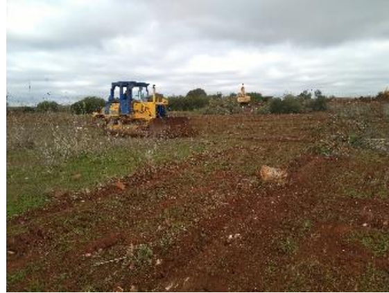
Desmatação e decapagem
