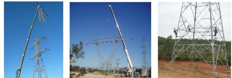
Montagem de apoios de linha
