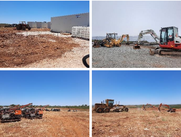
Operação de estaleiro e maquinaria de obra
